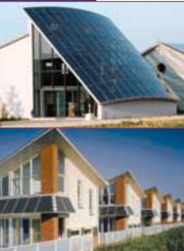
1. Iglstadt, Duitsland. Industriegebouw Bauer Energietechnik ( www.solarintegration.de ). 2. Dordrecht, Nederland. 22 woningen (Bear Architecten).
